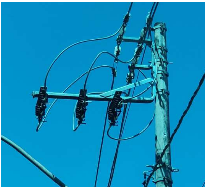
Figura 9– Chave Seccionadora.
