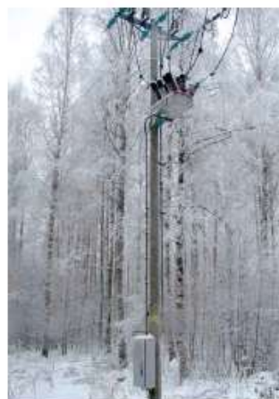
RELIGADOR OSM E CABINE DE CONTROLE E COMUNICAÇÕES RC
