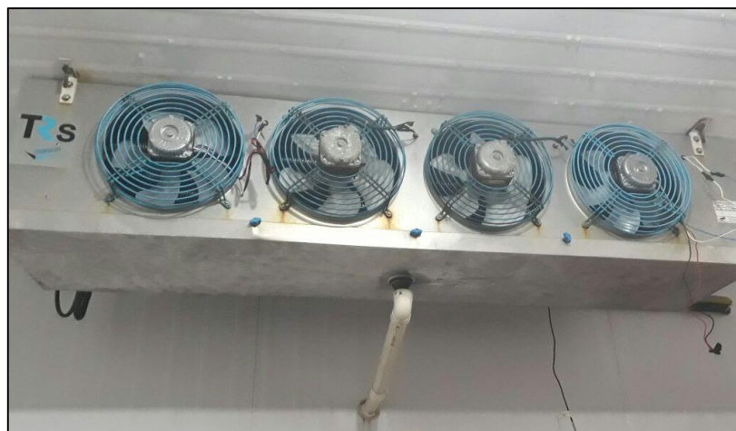
Figura 9 - Evaporador frigorífico de ar forçado TRSD-411PEN
