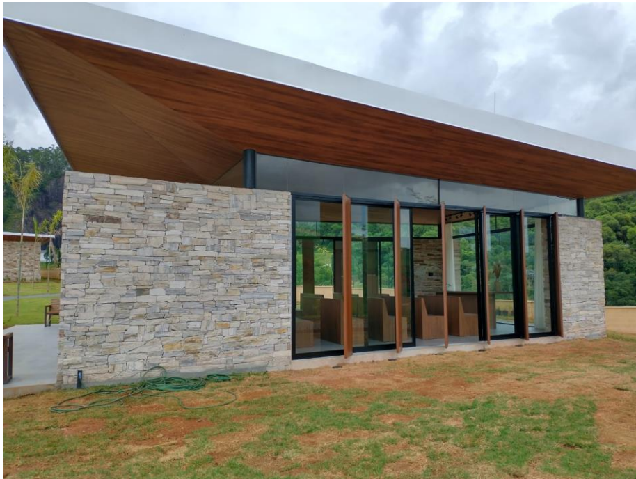
Figura: imagem do revestimento do Espaço Ecumênico
