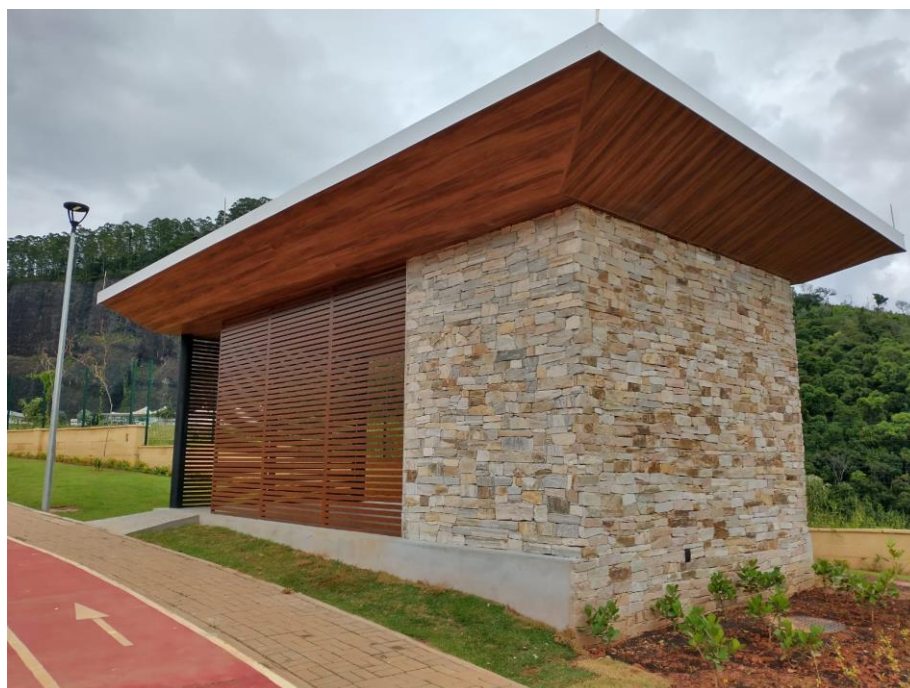
Figura: imagem do revestimento do banheiro do Espaço Ecumênico
