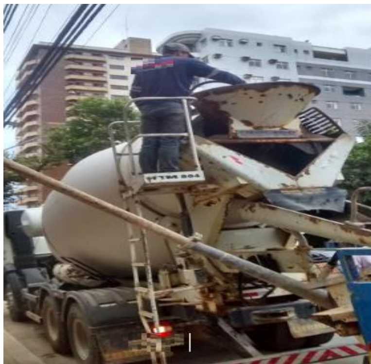
Figura 36: Ajuste da consistência do concreto
