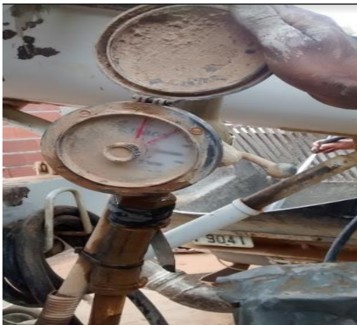
Figura 42: Ajuste da consistência do concreto
