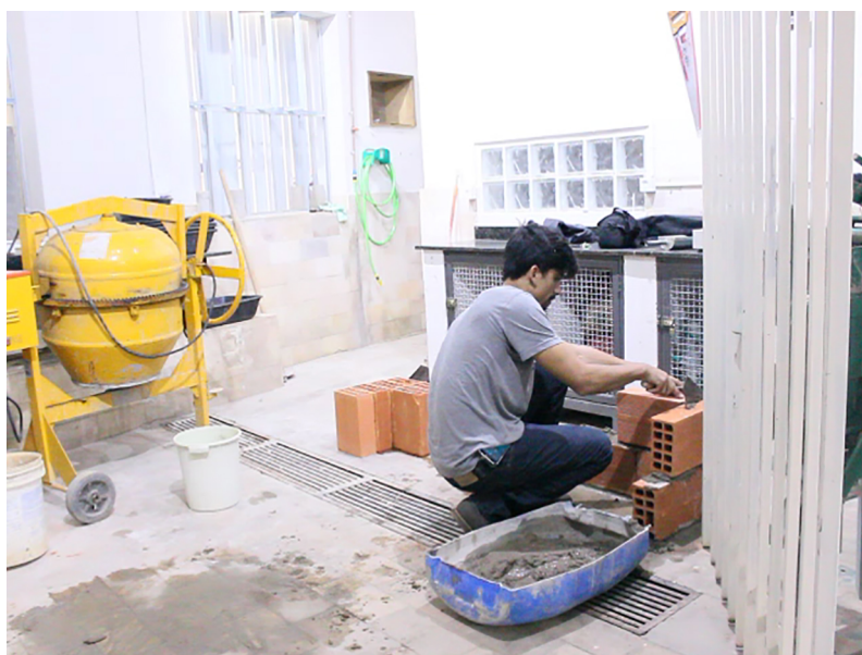
Figura 7: Execução do Serviço de Alvenaria.
