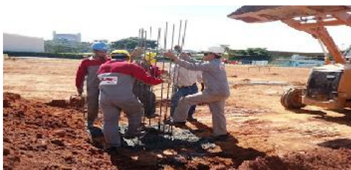
Figura 7 - Colocação da armadura
