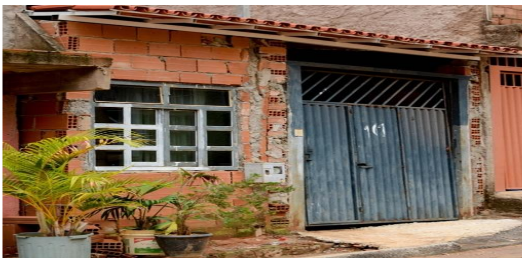
Figura 16 Construção 05 com paredes autoportante
