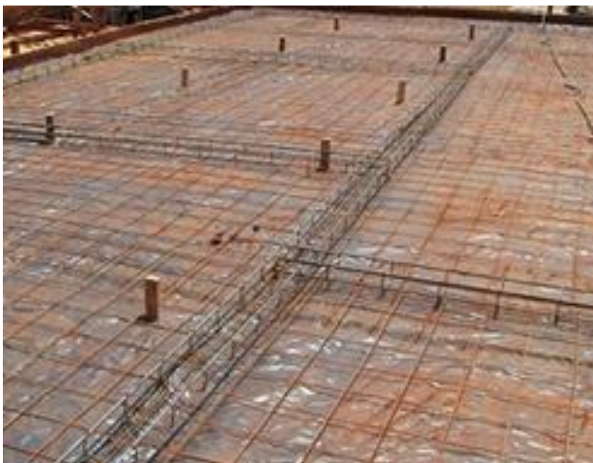
Figura 14 Fundação em grelha
