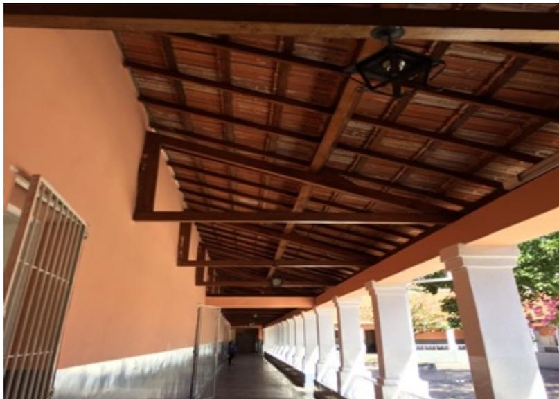
**Figura 4:** Armação do Telhado em Madeira
