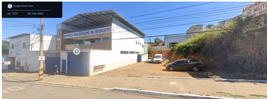
Imagem 6: vista frontal do edifício do SEVOR e do lote.
