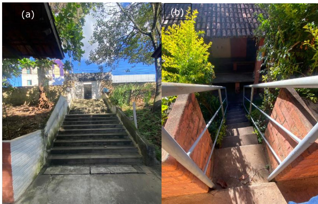
Figura 6: Entrada principal (a), acesso ao pátio (b)
