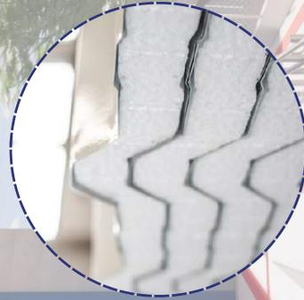
2- Substituição de telha existente por telha termoacústica sanduiche com a intenção de amenizar o desconforto térmico em dias muito quentes e reduzir o desconforto sonoro em caso de chuva.
