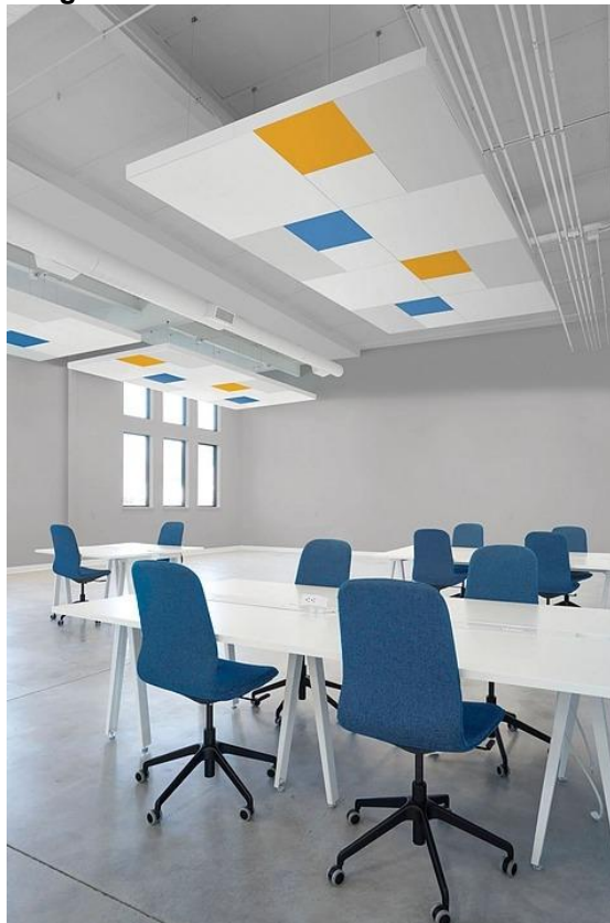
Imagem 13: Nuvem acústica instalada no teto.
