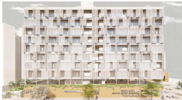
Figura 21: Fachada frontal do Centro de Acolhimento
