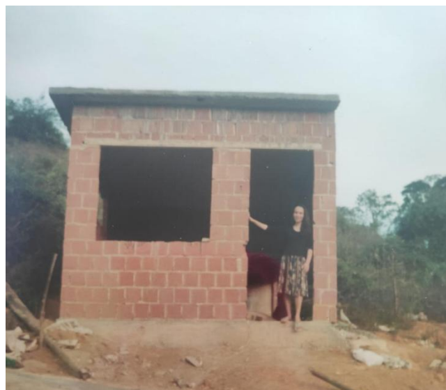
imagem 07: Imagem da fachada da casa ainda em construção.
