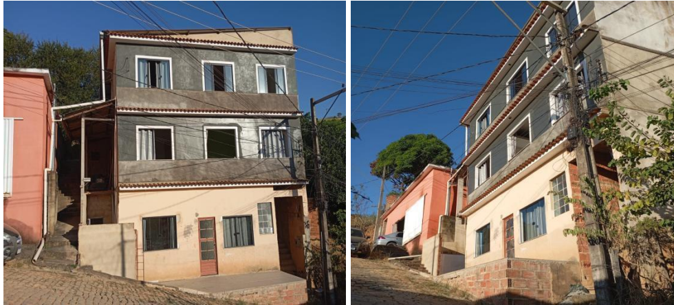
Imagem 15: Imagens do prédio de 3 andares que fica a frente da residência
