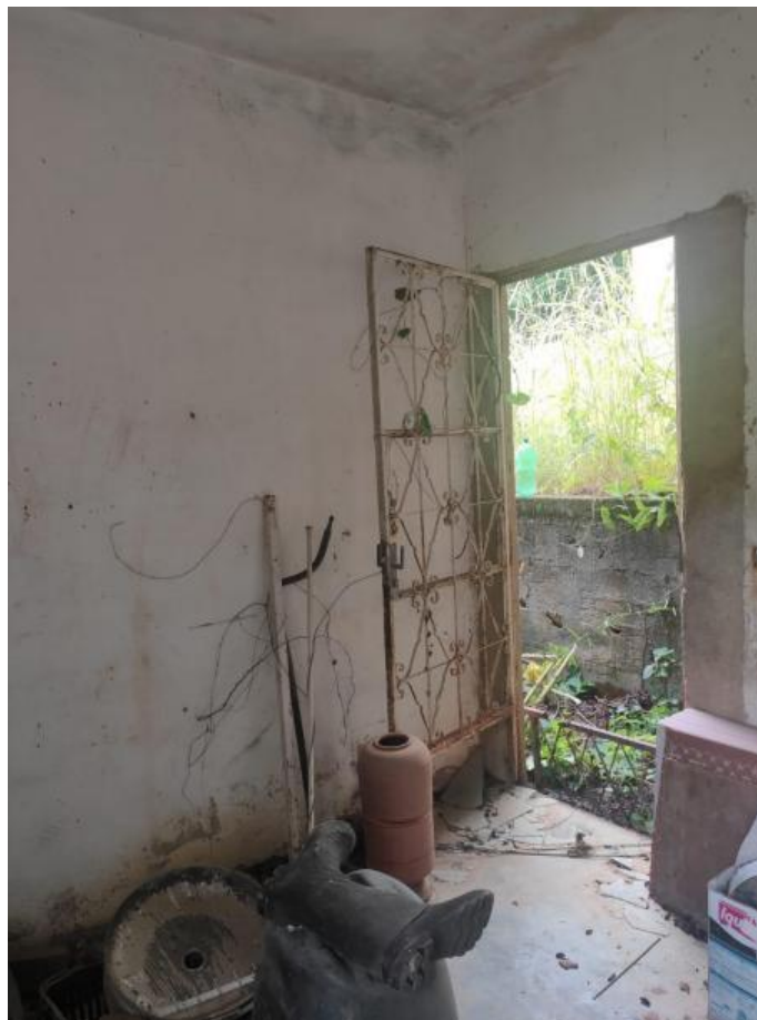
Imagem 21: Imagem do estado atual da cozinha
