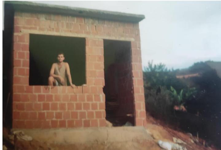
imagem 08: Imagem da fachada da residência, mostrando parte do terreno sem construção
