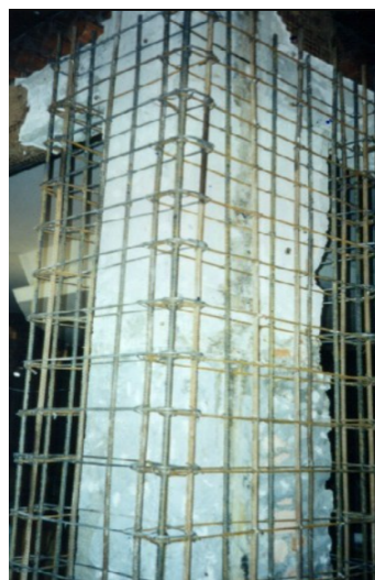
Imagem 25: Imagem do encamisamento pilar
