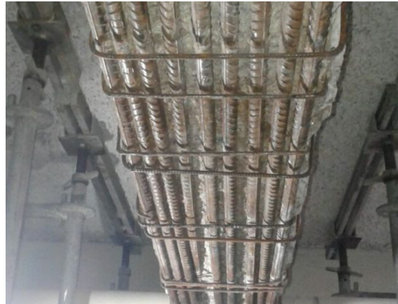
Imagem 26: Imagem do encamisamento pilar
