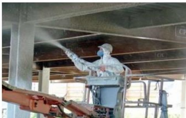
Figura 5 – Aplicação de argamassa projetada
