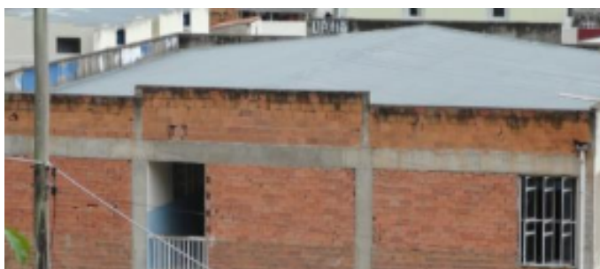
Figura 26: Vista da área disponível nos telhados do bloco D.
