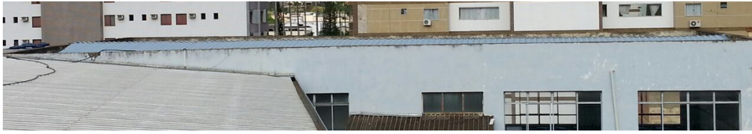
Figura 23: Vista da área disponível nos telhados do bloco B.
