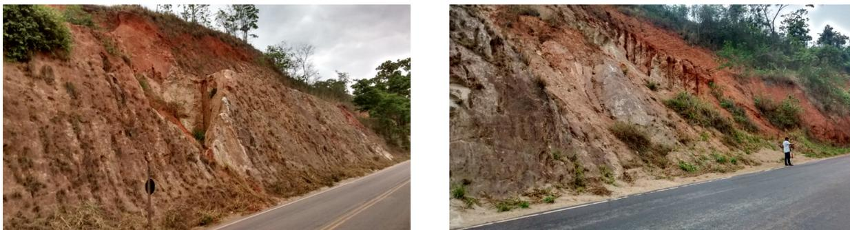
**Figura 22:** Talude com erosão situado as margens da rodovia.
