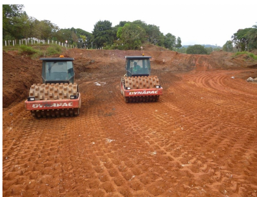
Figura 8: Compactação de Solo.
