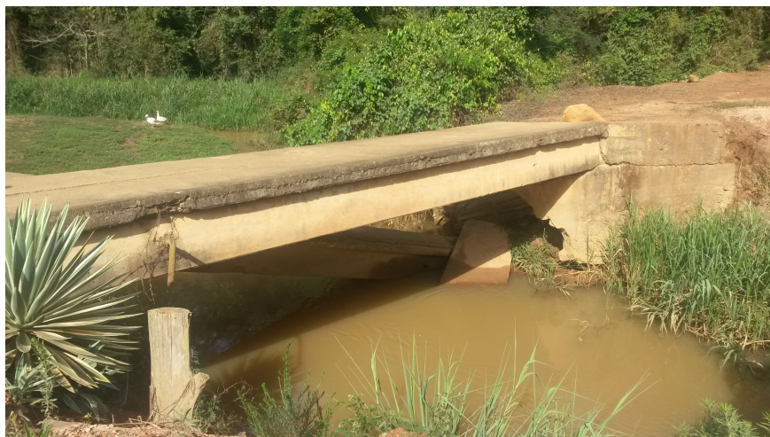
Figura 10: Ponte Córrego do Laje (Autoria Própria)
