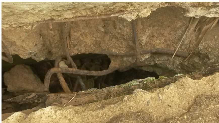
Figura 15: Exposição da Armadura (Autoria Própria)
