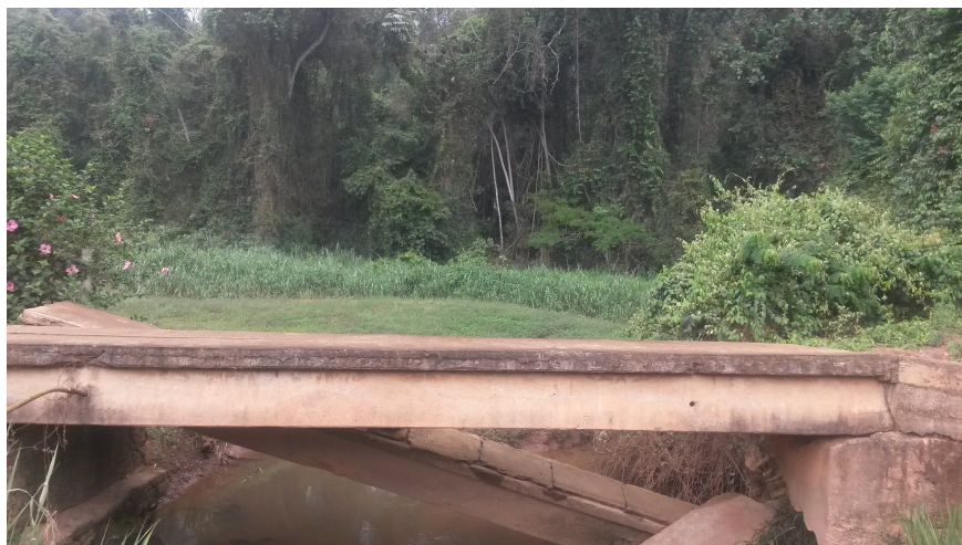
Figura 12: Viga e Tabuleiro Caídos(Autoria Própria)
