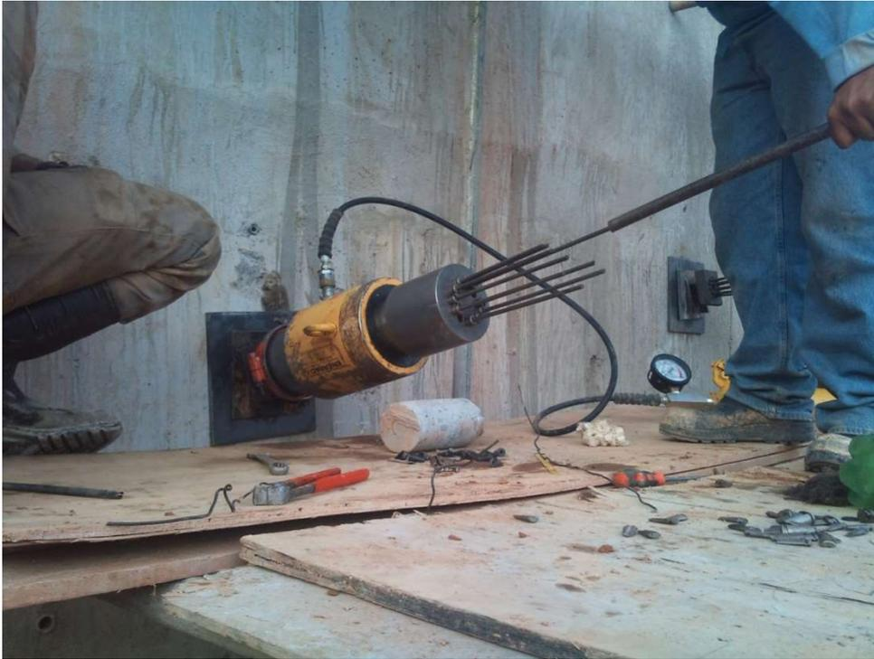
*Figura 2-14. Montagem do conjunto manômetro-macaco-bomba hidráulico. (Assuntos cruzados)*
