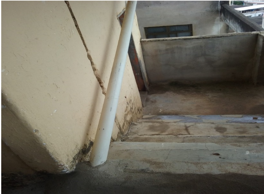
Figura 22: Foto da escada de acesso a cobertura
