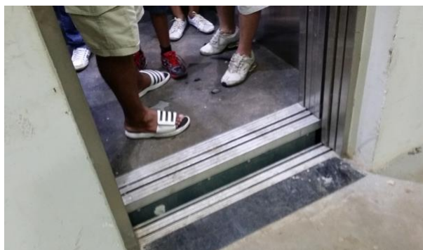
Figura 18: Problema no elevador
