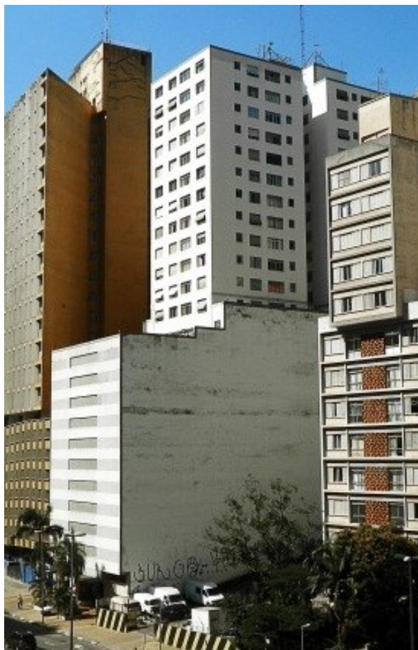
Figura 4: Edifício-Garagem Saint Patrick.
