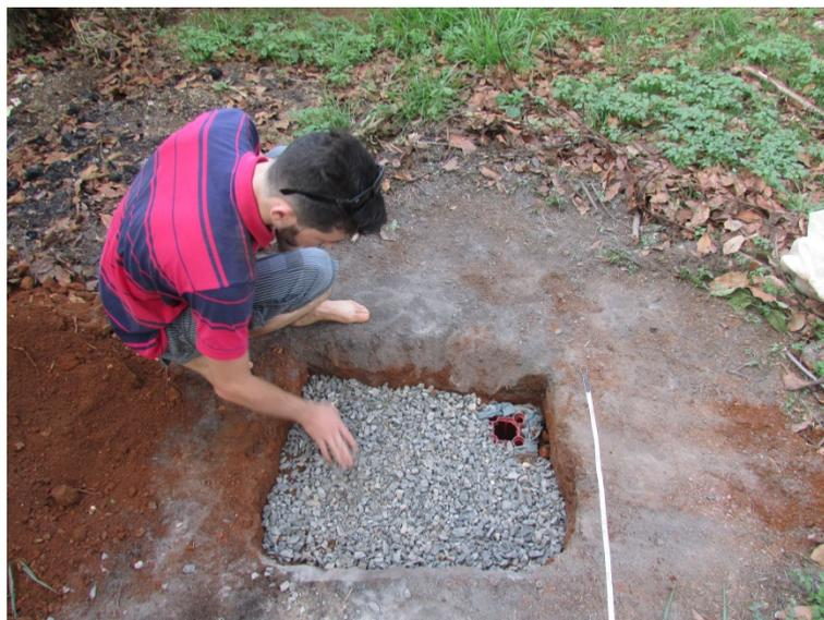
**Figura 15:** Revestimento da parte superior, com tecido de algodão e britas 3/4. Acervo dos autores.
