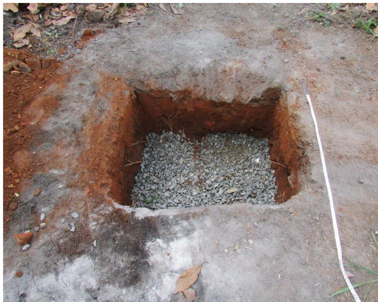
**Figura 13:** Nivelamento do fundo com brita 3/4. Acervo dos autores.
