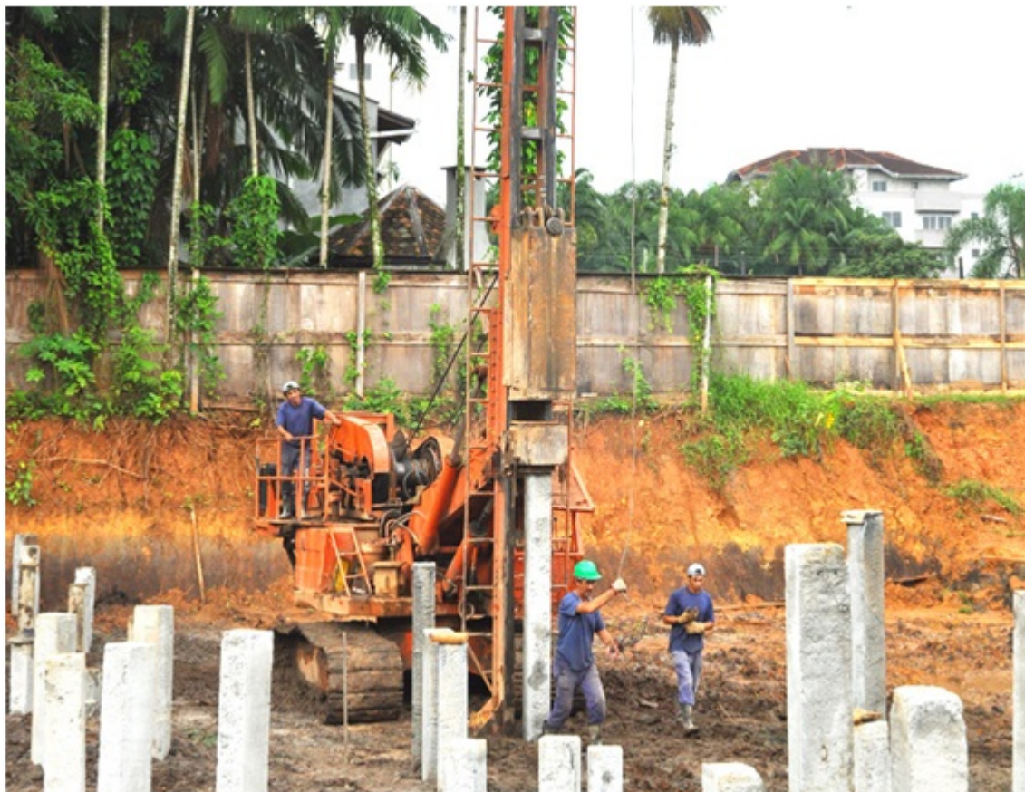
Figura 34: Cravação de estacas com o uso do martelo de gravidade.
