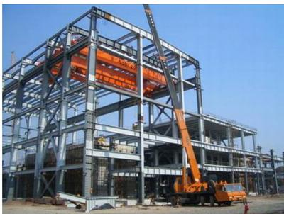
**Figura 1:** Estrutura em aço (Disponível em: <<http://www.steelstructureschina.com/Steel-Structure-for-Power-Plant-Industry.htm>>).
