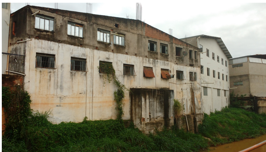
Figura 12: Vista de edificação às margens do Rio Caratinga
