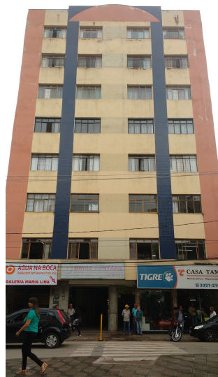
Figura 9: Edifício Maria Lina, Caratinga-MG
