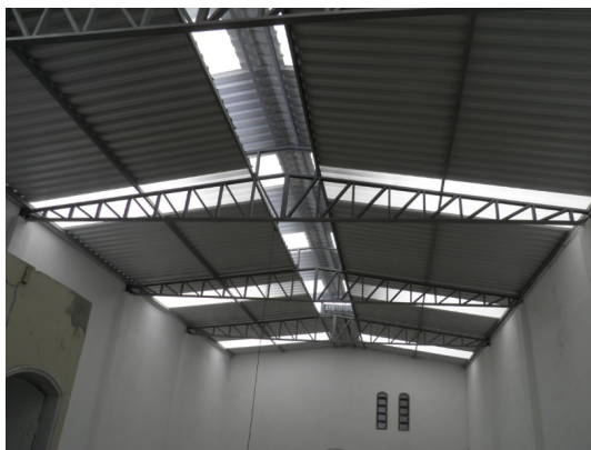
Figura 23: Cobertura com telhas galvanizadas.
