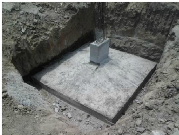
Figura 15: Sapata isolada.
