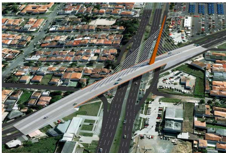
Figura 10 – Interconexão em nível superior sem ramos
