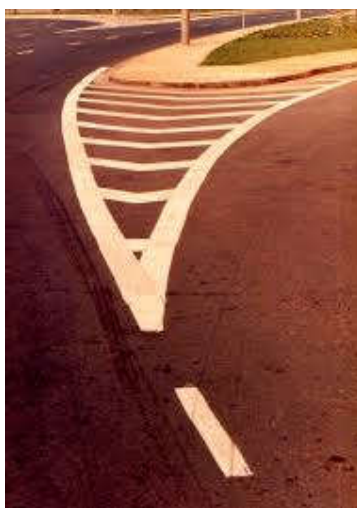
Figura 29 – Sinalização horizontal: marcas de canalização
