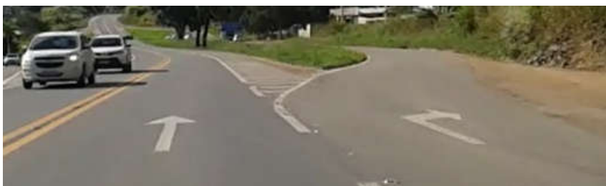
Figura 50 – sinalização horizontal indicando os sentidos do tráfego
