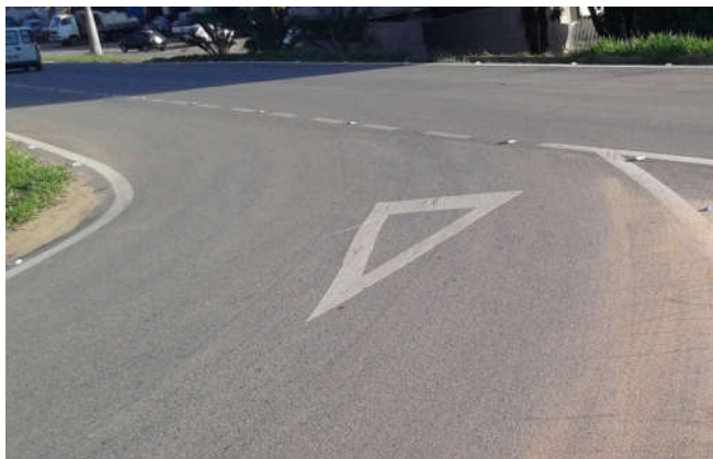
Figura 43 – Sinalização horizontal de indicação de preferência
