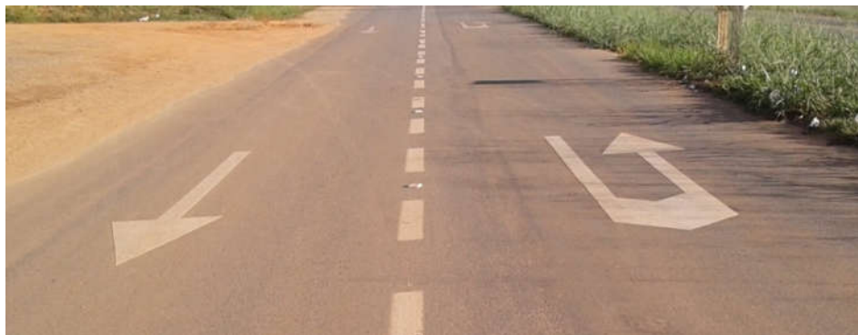
Figura 49 – Sinalização horizontal indicando o sentido do tráfego
