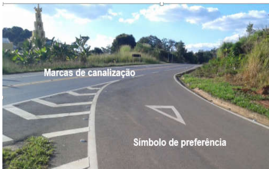
Figura 46 – Sinalização horizontal de canalização e preferência
