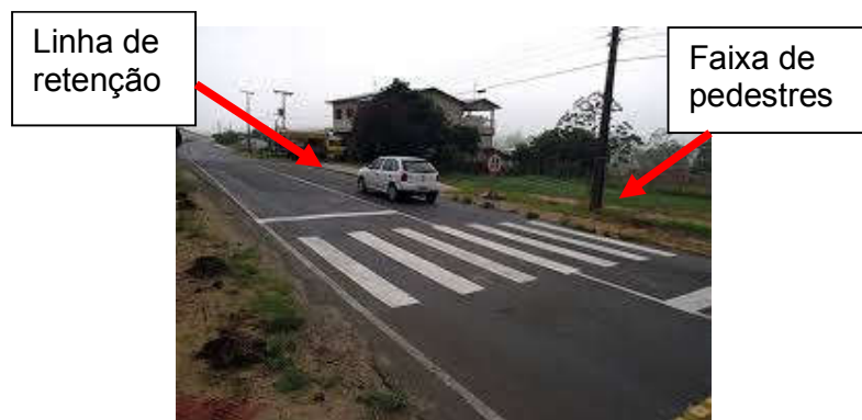
Figura 28 – Sinalização horizontal: marcas transversais
