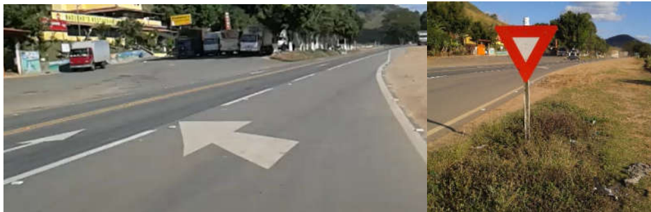
Figura 45 – Sinalização horizontal de direção e vertical de preferência
