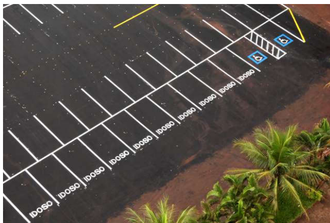
Figura 30 – Sinalização horizontal: controle de estacionamento
