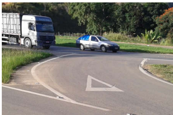
Figura 48 – Sinalização horizontal de preferência
