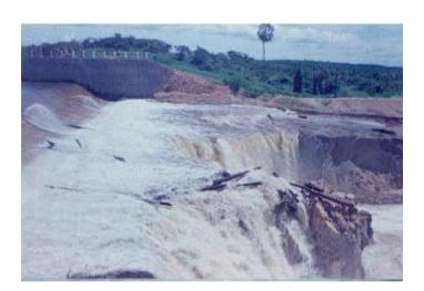
Figura 3: Erosão regressiva no sangradouro da Barragem Itaúna.
