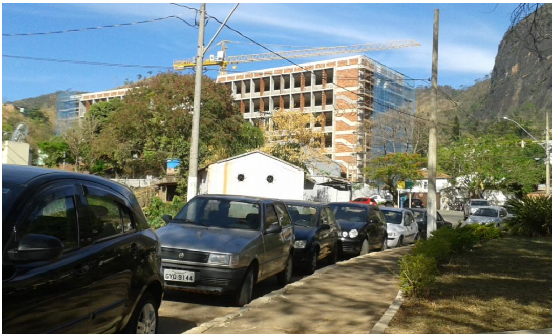
Figura 5 - Construção do novo Tribunal de Justiça- Fórum da Comarca de Caratinga
