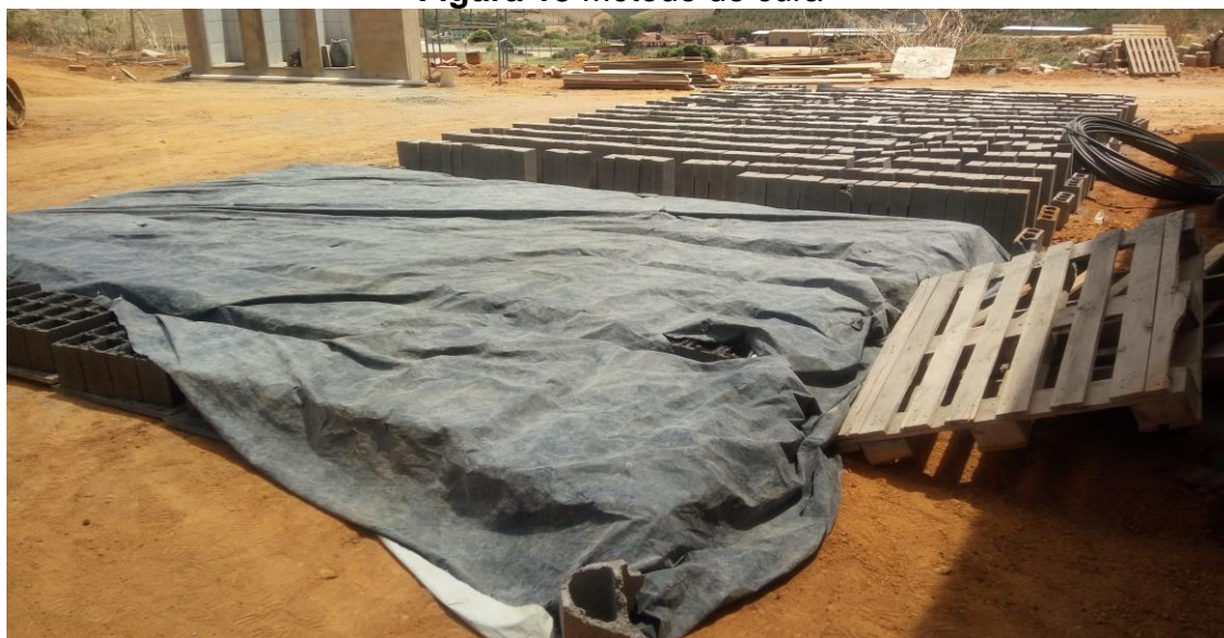
Figura 13 Método de cura
