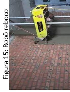
Figura 15: Robô reboco
