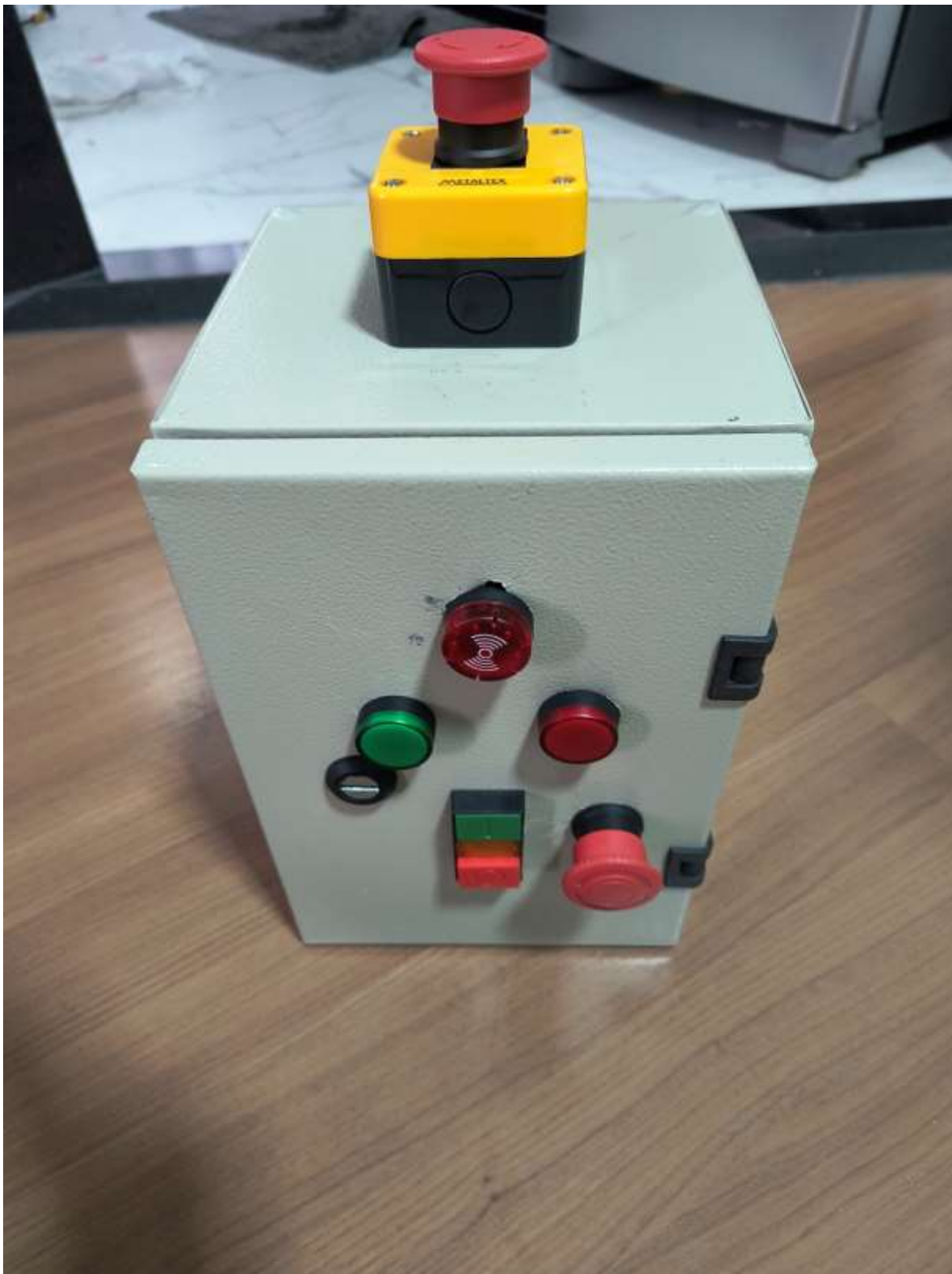
Figura: 8 – Instalados Componentes
