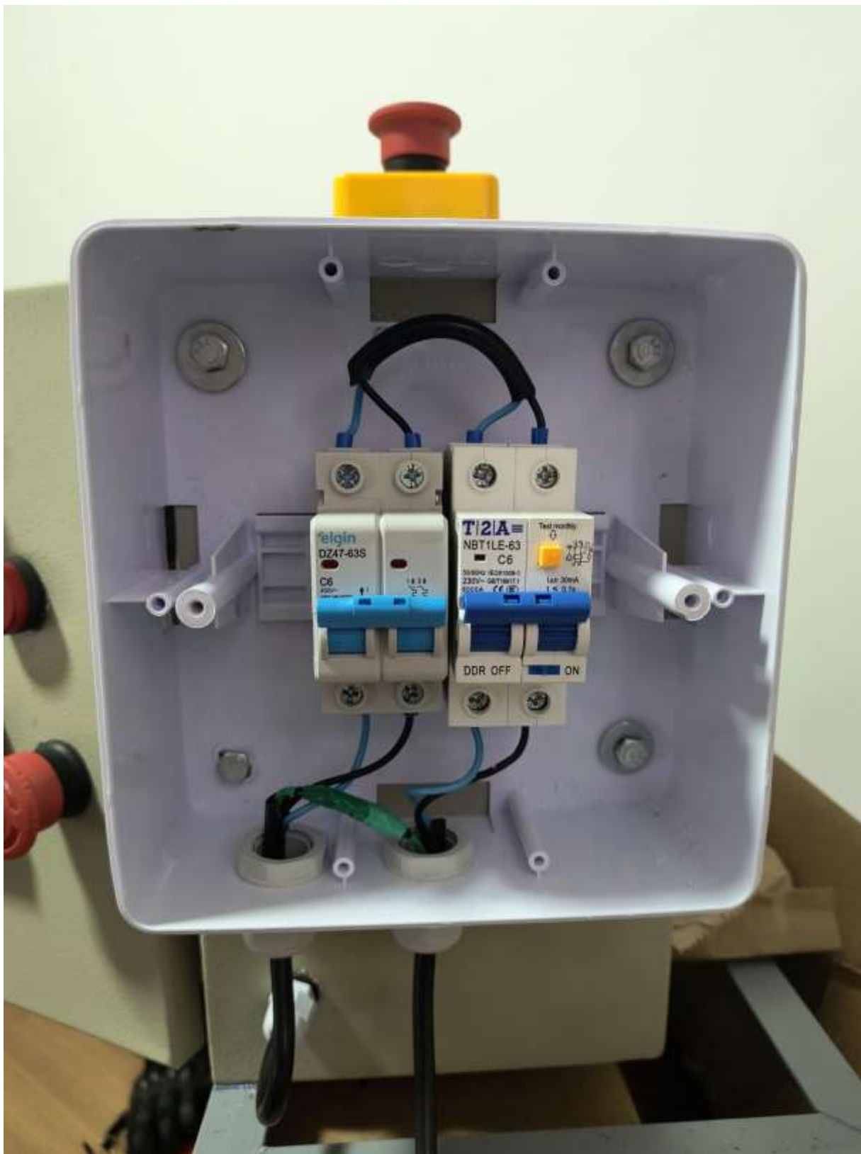
Figura: 9 – Instalação e Ligação dos Disjuntores
