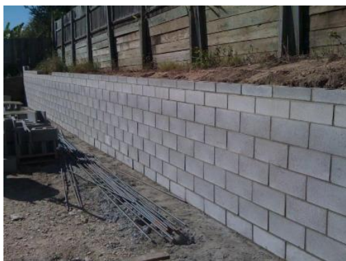
Figura 3 – Muro de arrimo de alvenaria estrutural
