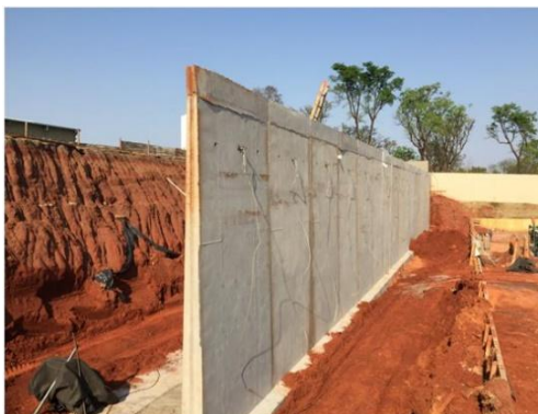
Figura 2 – Muro de flexão em concreto armado
