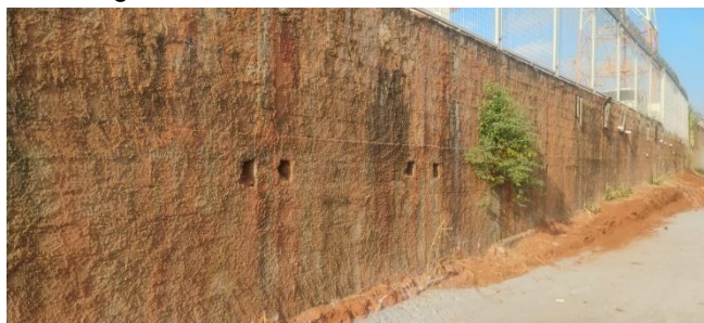
Figura 5 – Vista geral do muro de arrimo analisado no estudo de caso
