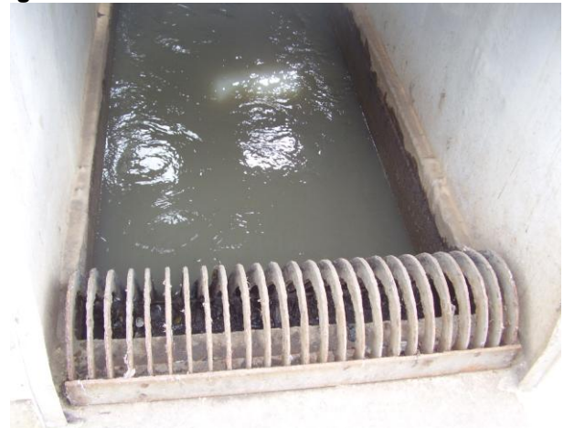
Figura 7: Gradeamento
