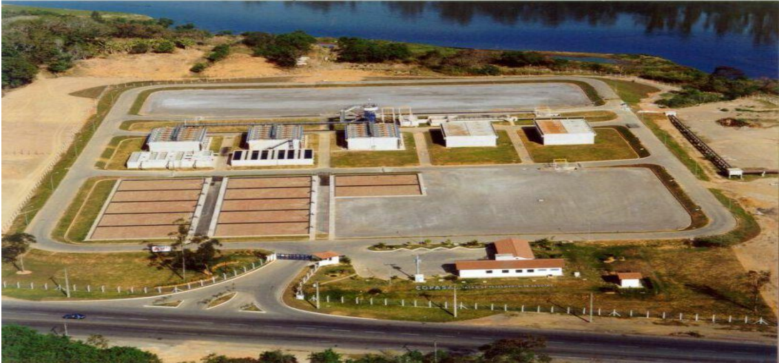
Figura 5: Estação de tratamento de esgoto de Ipatinga (ETE IPANEMA).
