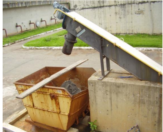
Figura 17: Resíduo do desarenador (areia)
