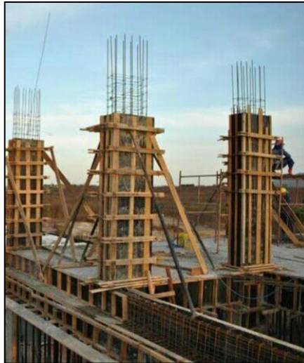
Figura 7 - Pilares de uma construção
