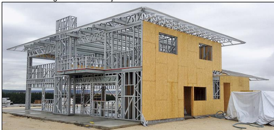
Figura 2 - Construção de residência em Steel Frame .
