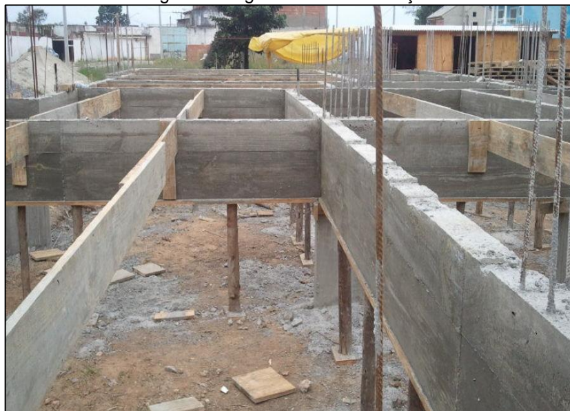
Figura 6 - Vigas de uma construção
