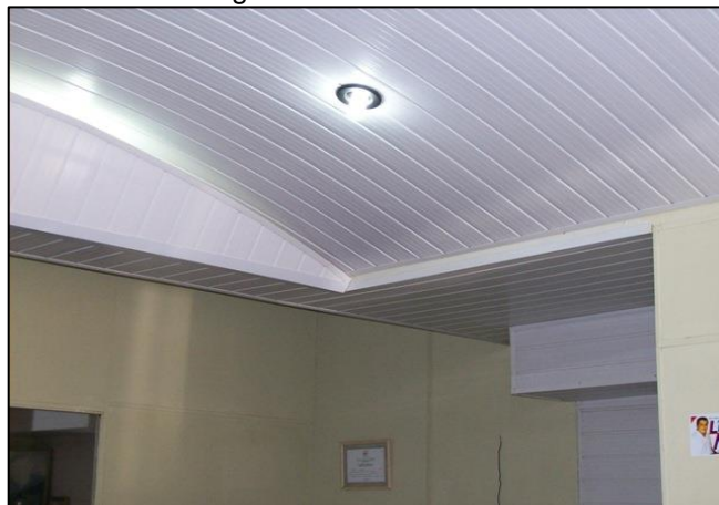
Figura 9 - Forro em PVC
