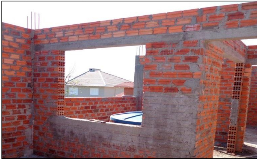
Figura 3 - Construção de residência em alvenaria convencional.
