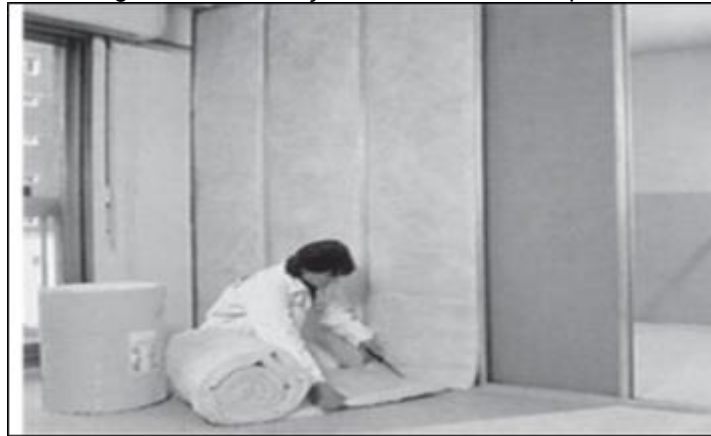
Figura 29 - Instalação da lã de vidro em painel
