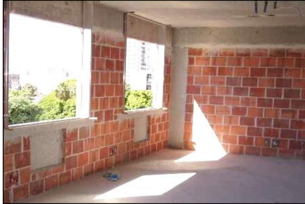
Figura 8 - Alvenaria de vedação em tijolos vazados
