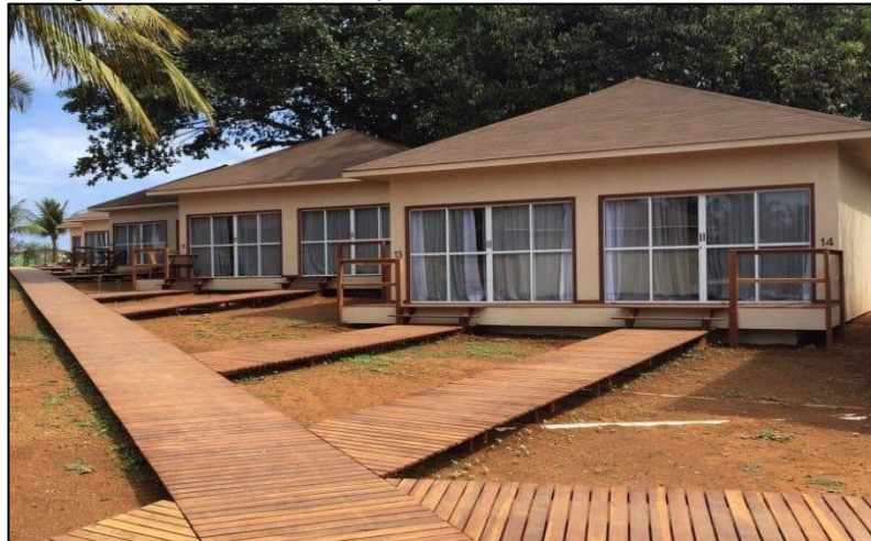
Figura 15 - Obra de uma pousada em Fernando de Noronha.
