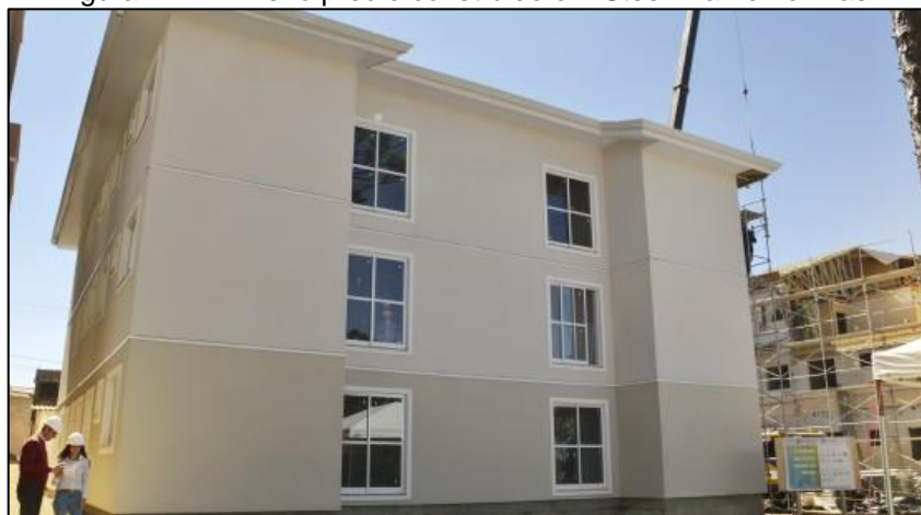
Figura 17 - Primeiro prédio construído em Steel Frame no Brasil
