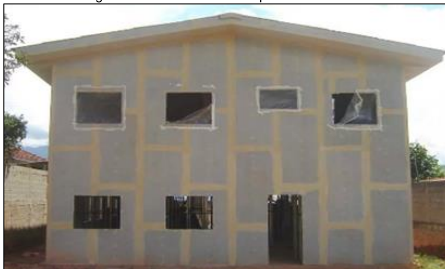
Figura 28 - Fechamento com placas cimentícias
