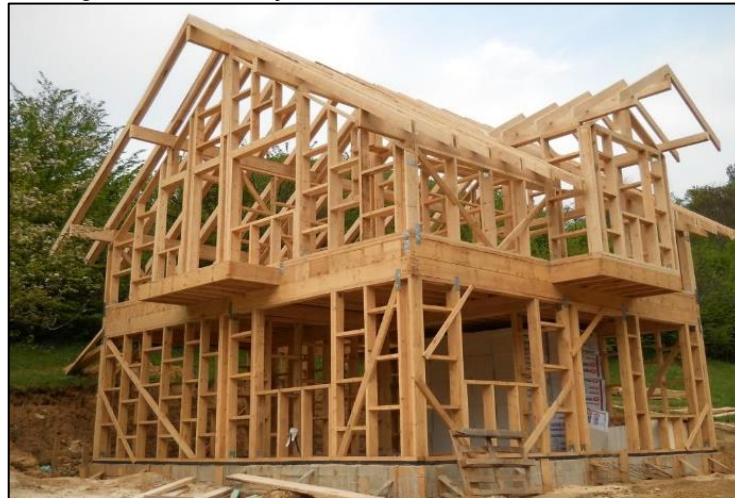
Figura 1 - Construção de residência em Wood Frame .
