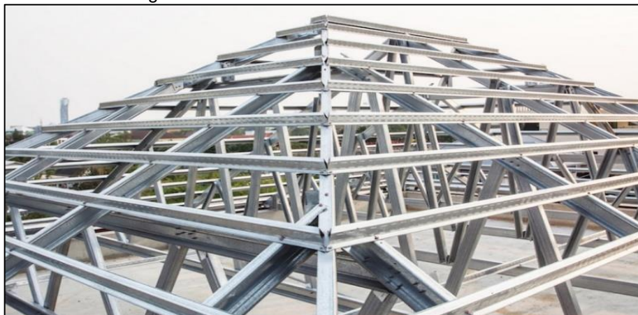
Figura 39 - Cobertura no Sistema Steel Frame
