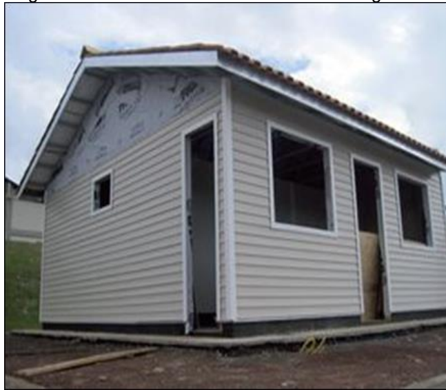
Figura 27 - Revestimento externo com Siding vinílico
