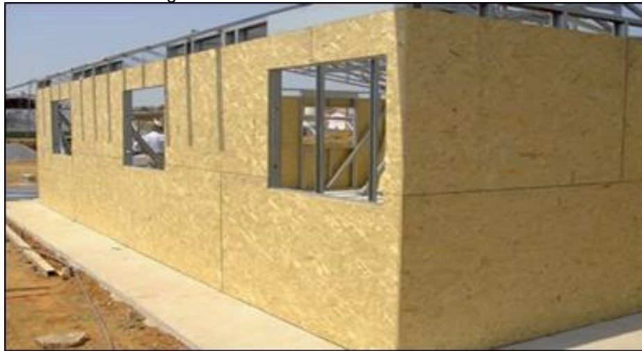
Figura 26 - Fechamento externo com OSB
