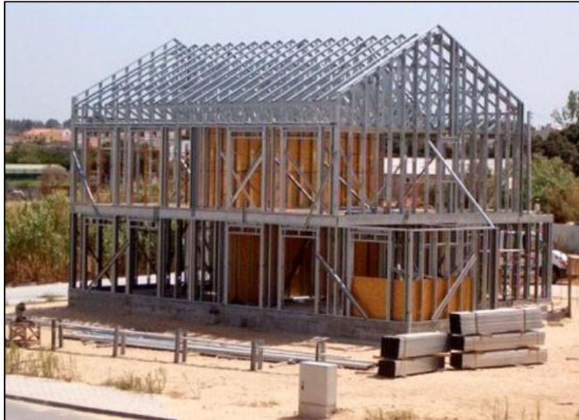
Figura 36 - Estrutura em Steel Frame
