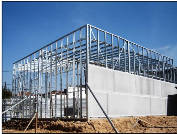
Figura 34 - Fechamento Steel Frame
