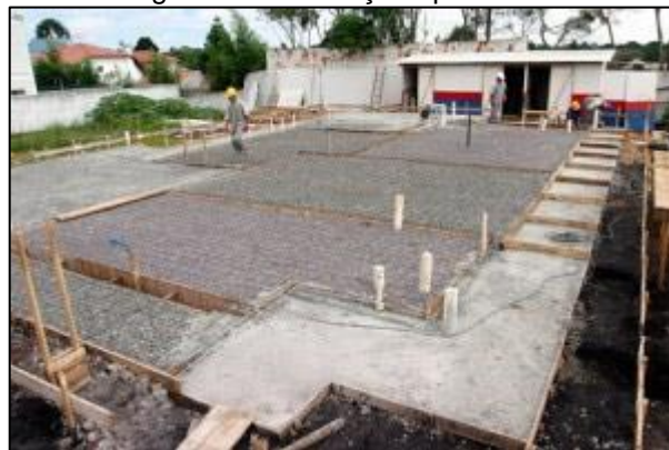
Figura 35 - Fundação tipo Radier
