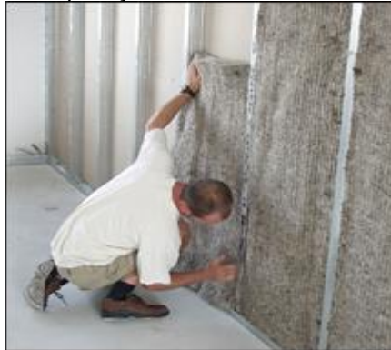
Figura 42 - Aplicação do Isolamento termo acústico
