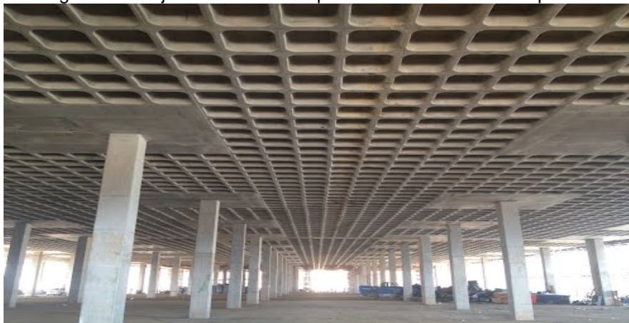
Figura 11 - Laje lisa nervurada apoiada diretamente sobre pilares
