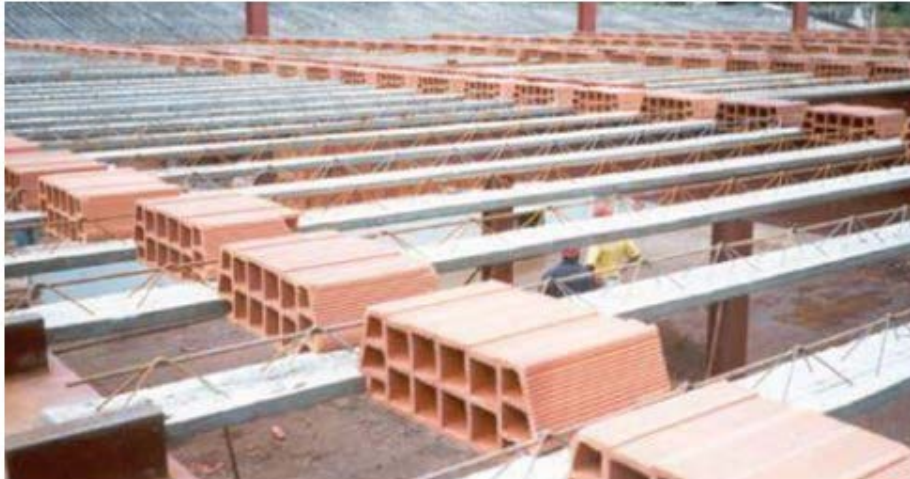
Figura 6 - Laje pré-moldada treliçada unidirecional
