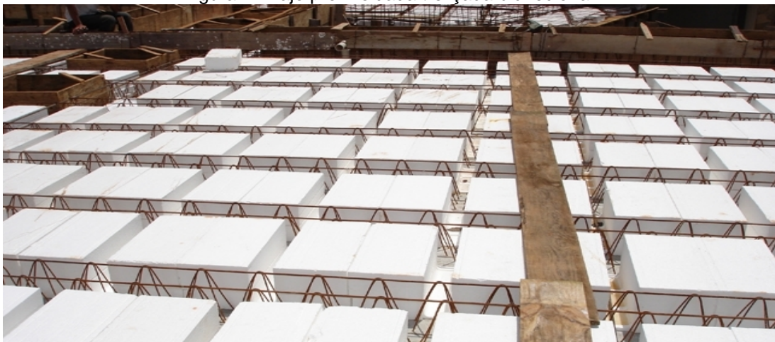
Figura 7 - Laje pré-moldada treliçada bidirecional
