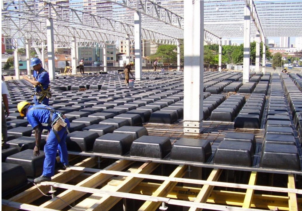
Figura 12 - Montagem das cubas de polipropileno
