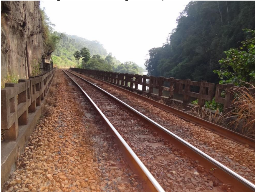
Figura 35 - Vista dos guarda corpos da Ponte
