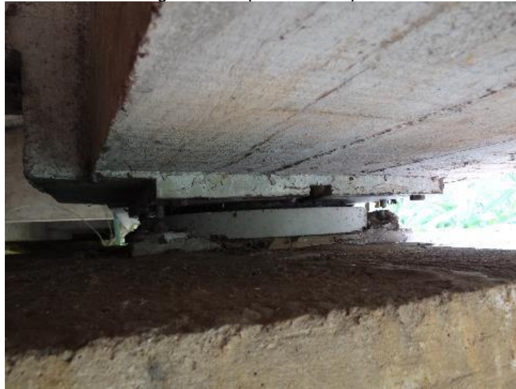
Figura 41 - Aparelho de apoio
