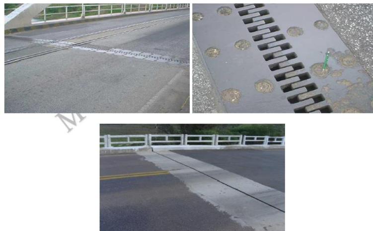
Figura 03 - Juntas de dilatação em tabuleiros
