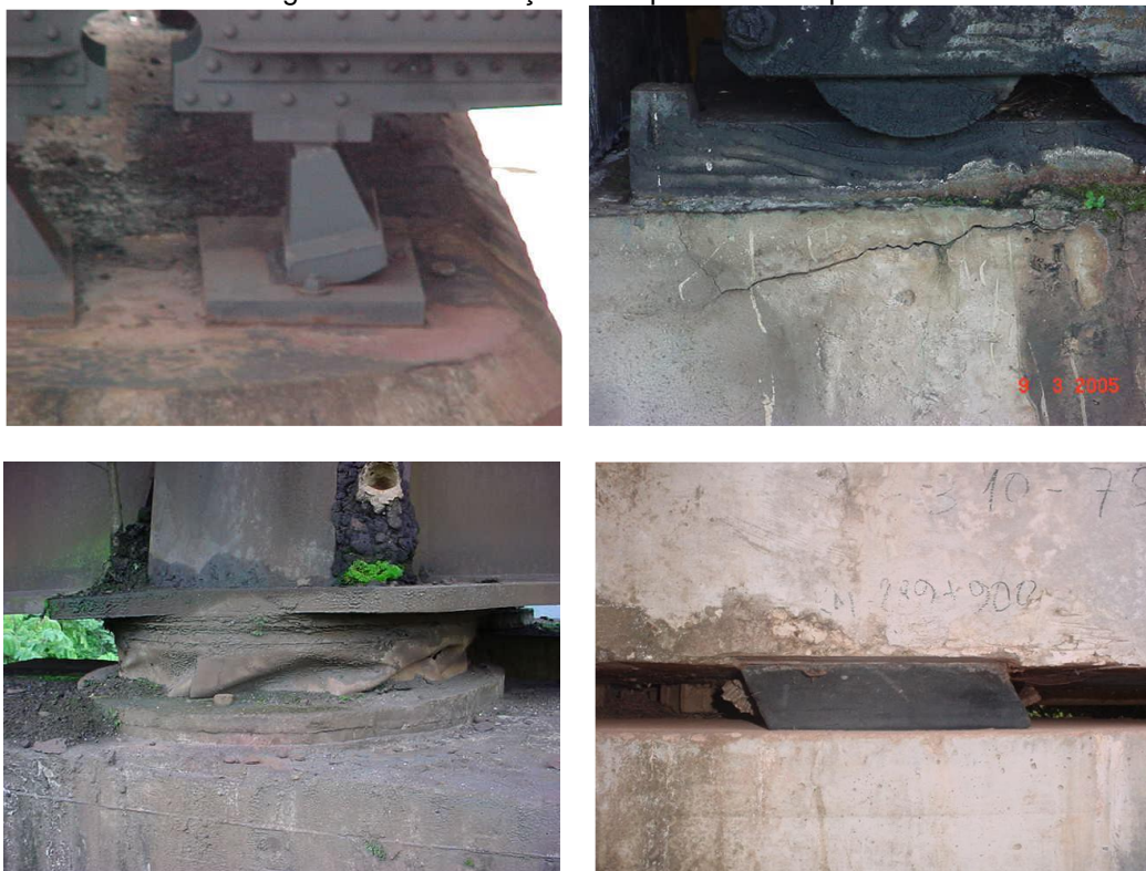
Figura 31 - Deformação nos aparelhos de apoios
