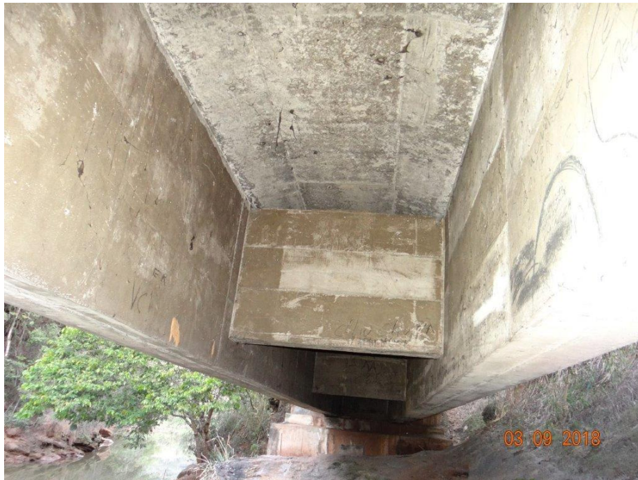
Figura 34 - Vista inferior da Ponte Dama
