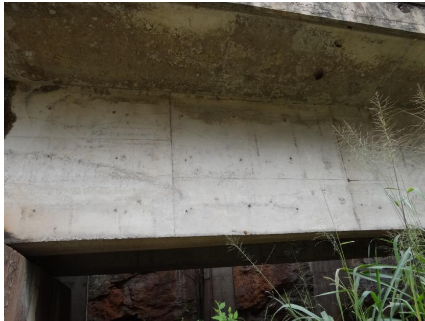
Figura 38 - Vista longitudinal da viga da Ponte Dama
