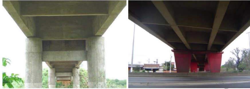
Figura 02 - Vigas sob tabuleiro
