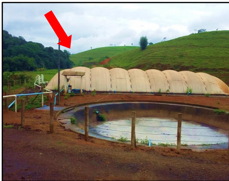
Figura 4 - Biodigestor anaeróbico (sistema de tratamento de dejetos bovinos)
