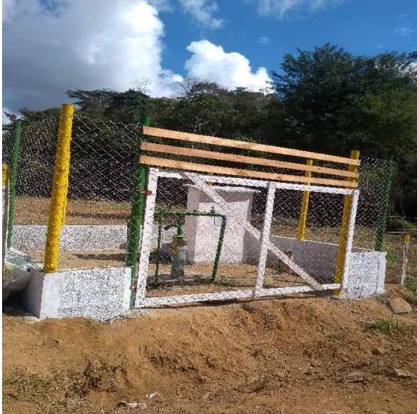
Figura 1: Construção da cerca
