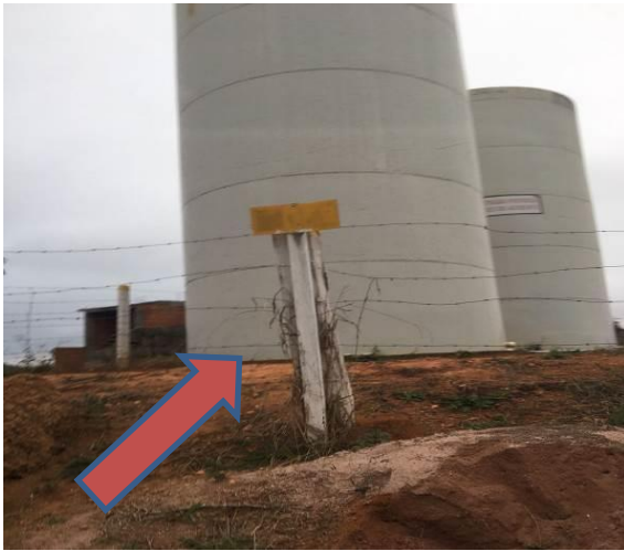
Figura 12: Caixa de distribuição d'água
