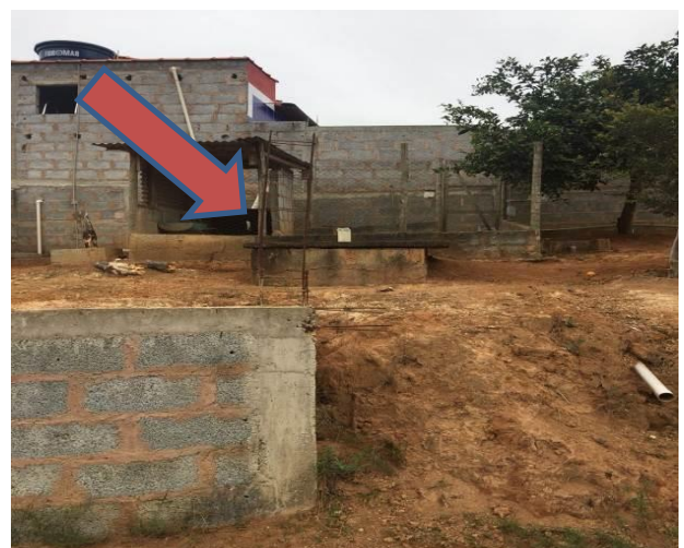
Figura 17: Fossa negra para esgotamento sanitário
