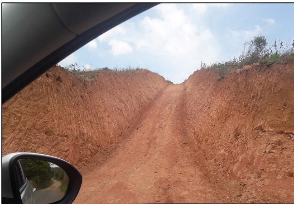
Figura 11 - Abertura de vias para acesso a novo loteamento.
