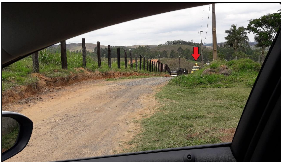
Figura 12 – Máquinas trabalhando em lote próximo à margem da represa
