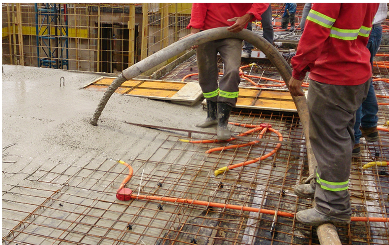
Figura 5: Concreto auto adensável
