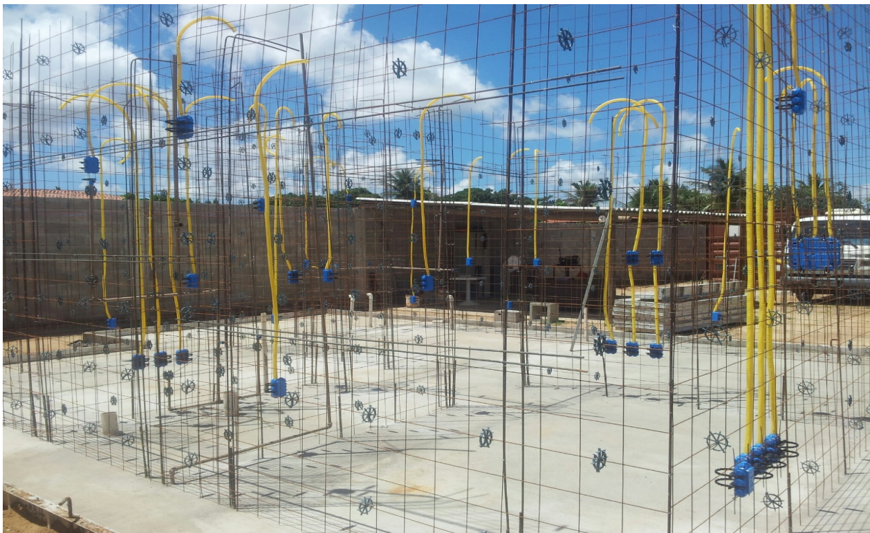
Figura 11: Armadura.
