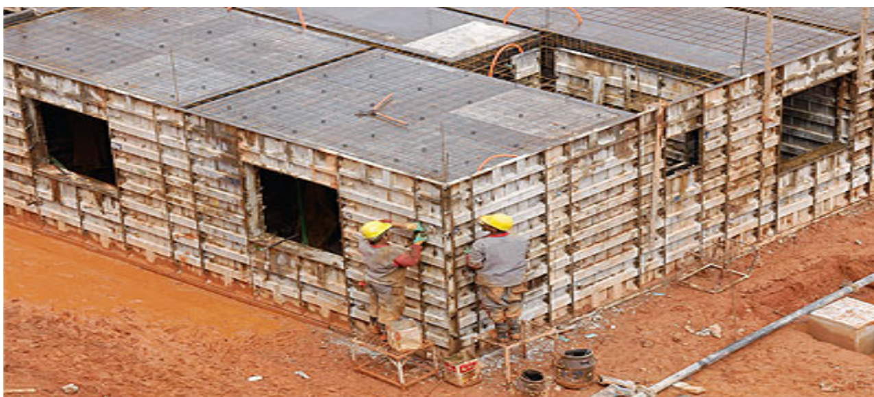
Figura 6: Forma metálica
