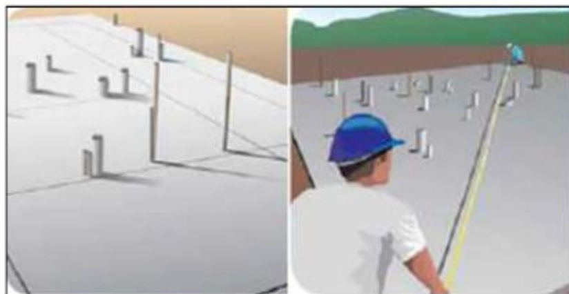
Figura 10 - Preparo e verificação do esquadro
