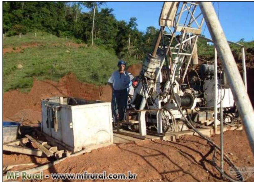
Figura 3 – Sondagem rotativa diamantada
