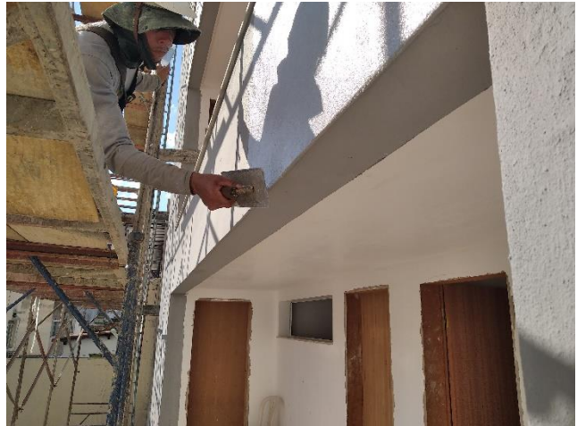
Figura 14 – Aplicação do Ecogranito
