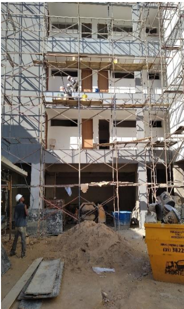
Figura 15 – Aplicação do Ecogranito
