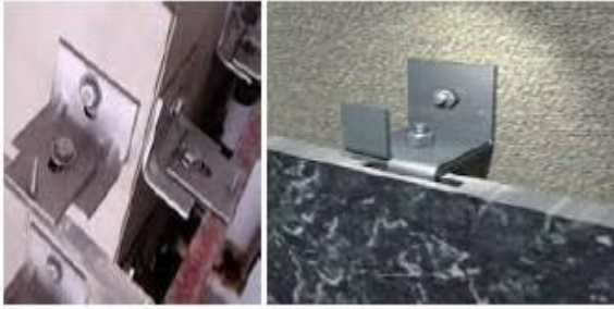
Figura 6: Inserts Instalados
