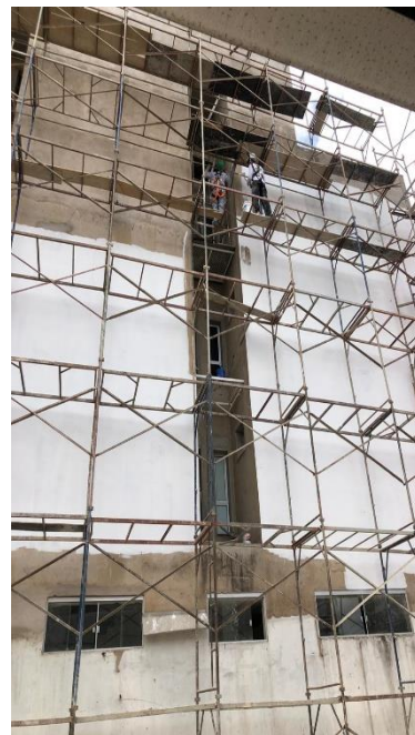
Figura 12 – Aplicação do Primmer
