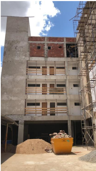
Figura 11 – Preparação da Superfície
