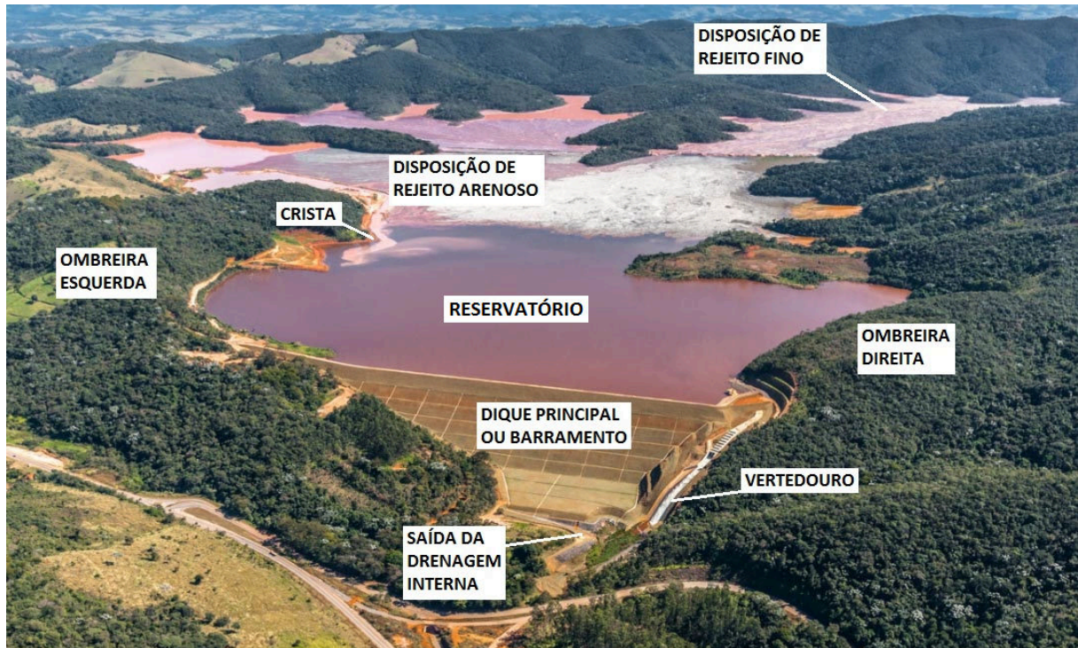
Figura 1 - Elementos constituintes de uma barragem de rejeitos.
