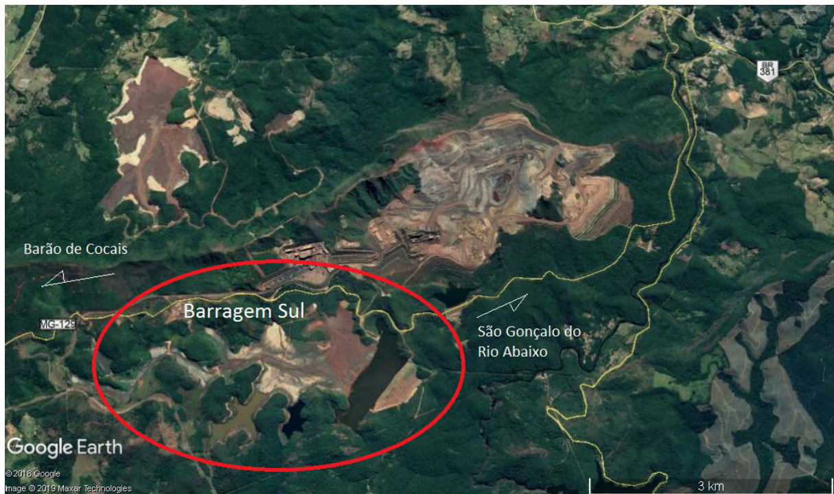
Figura 13 - Acesso à Barragem Sul da Mina Brucutu.
