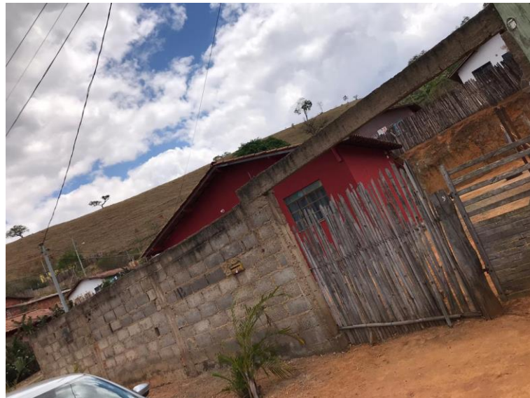
Figura 26 – Fachada com modificações
