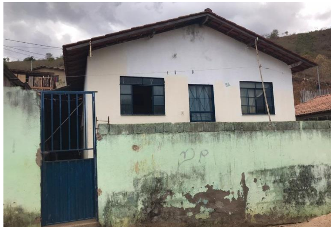
Figura 50 – Fachada frontal com muro e portão social
