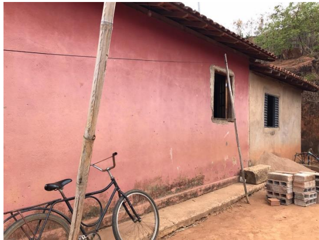
Figura 57 – Fachada lateral mostrando a ampliação
