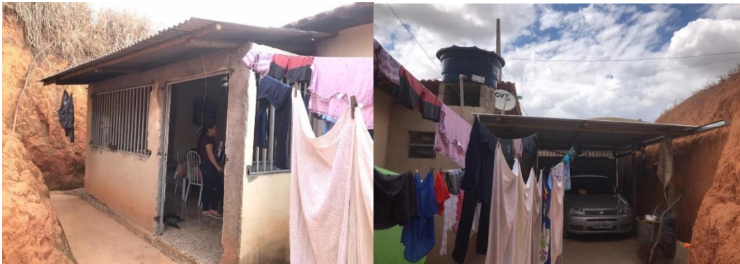
Figura 36 - Ampliação da cozinha e garagem
