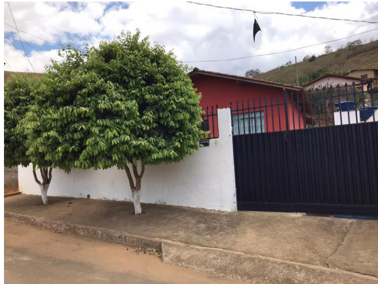
Figura 24 – Fachada com modificações
