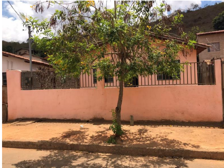
Figura 15 – Fachada frontal com muro e grade
