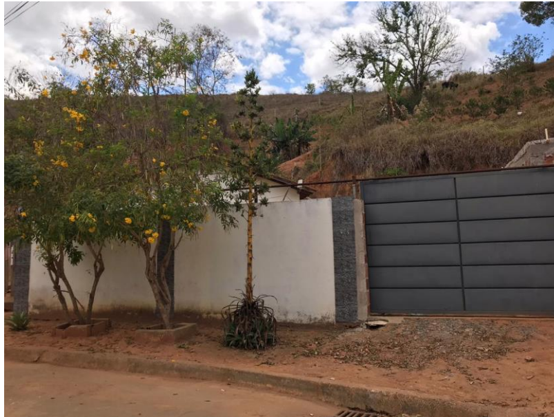
Figura 4 – Fachada frontal com muro e portão
