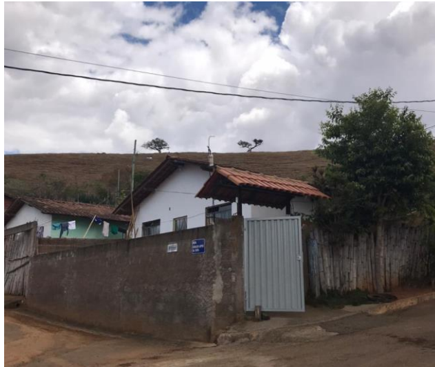
Figura 40 – Fachada com modificações
