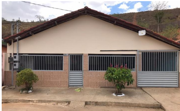
Figura 12 – Fachada frontal com extensão de varanda
