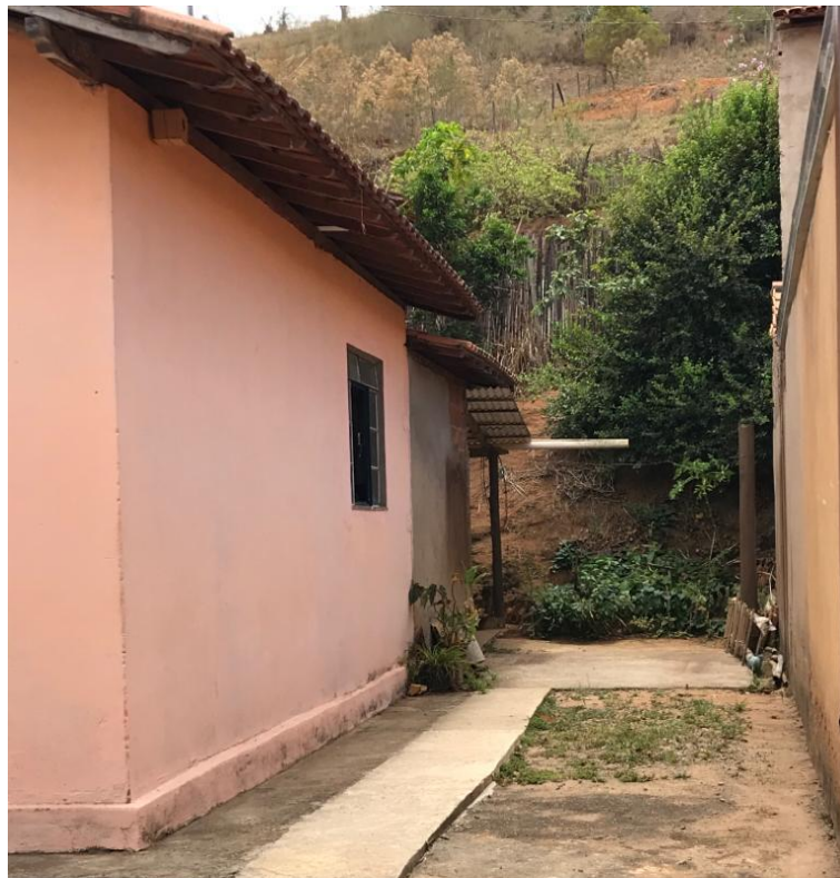
Figura 14 – Fachada lateral com a ampliação aos fundos
