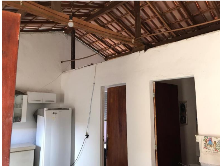
Figura 22 - Área interna das ampliações
