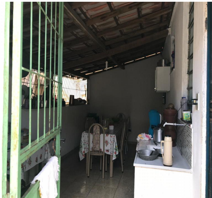
Figura 8 – Construção de uma cozinha
