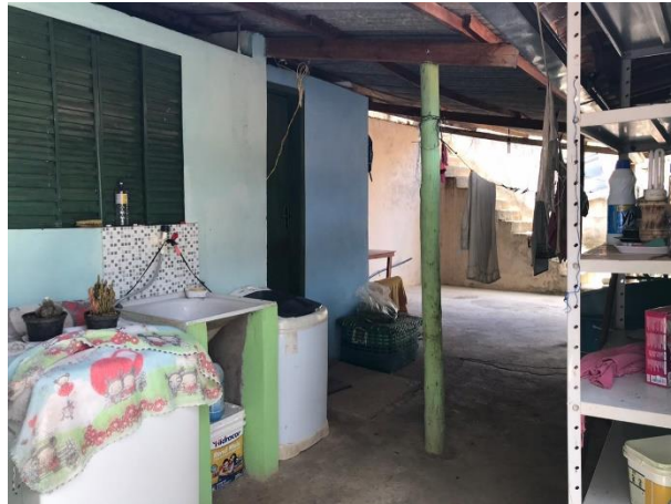
Figura 9 – Ampliação de varanda externa com quarto e banheiro
