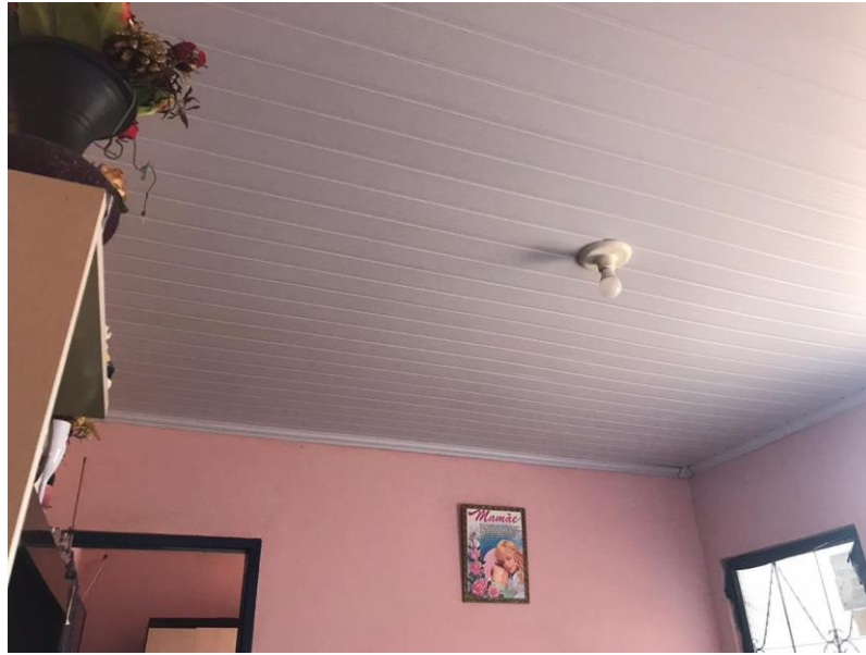
Figura 31 – Adição de forro PVC
