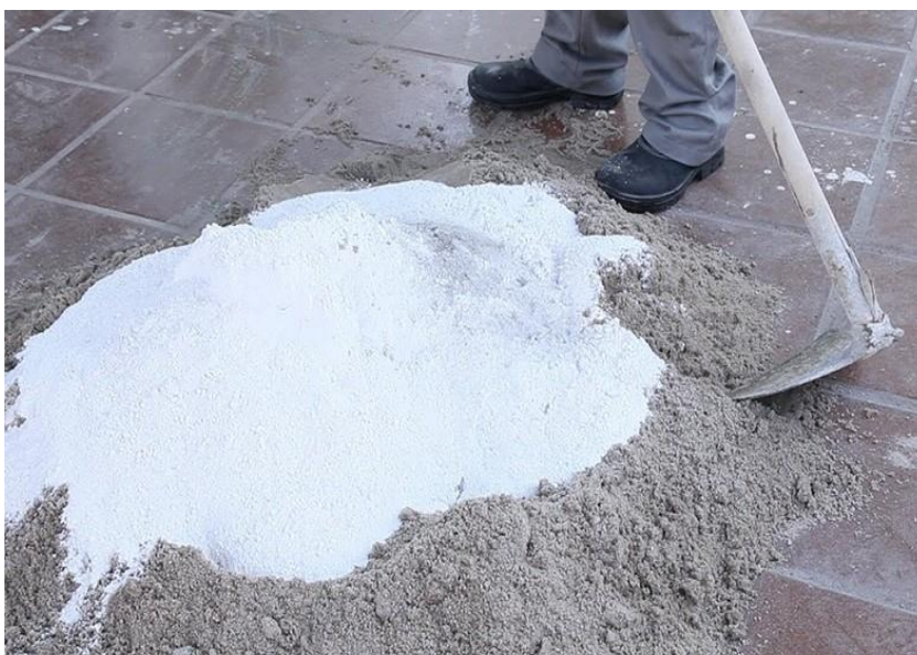
Figura 6: Adição de cal hidratada à argamassa
