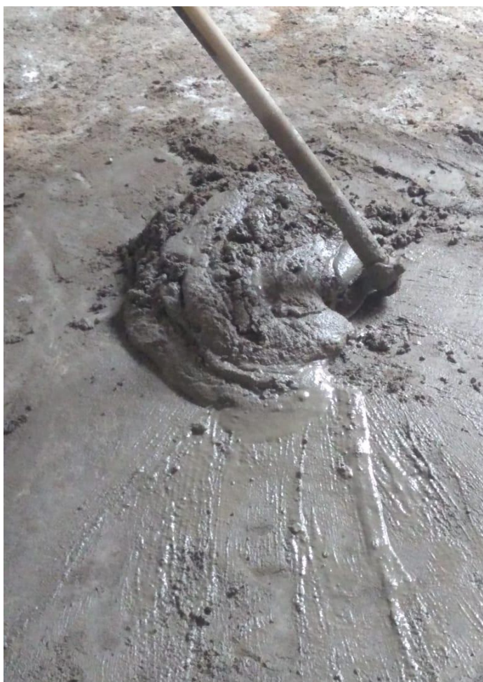
Figura 10: Utilização de argamassa com detergente na obra
