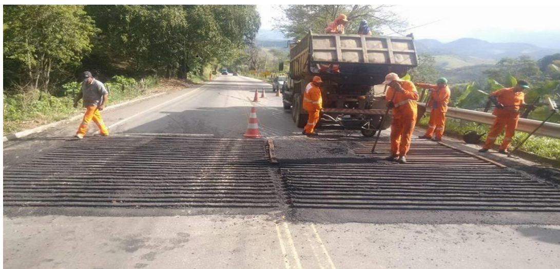
Figura 43 - Execução de ondulações transversais
