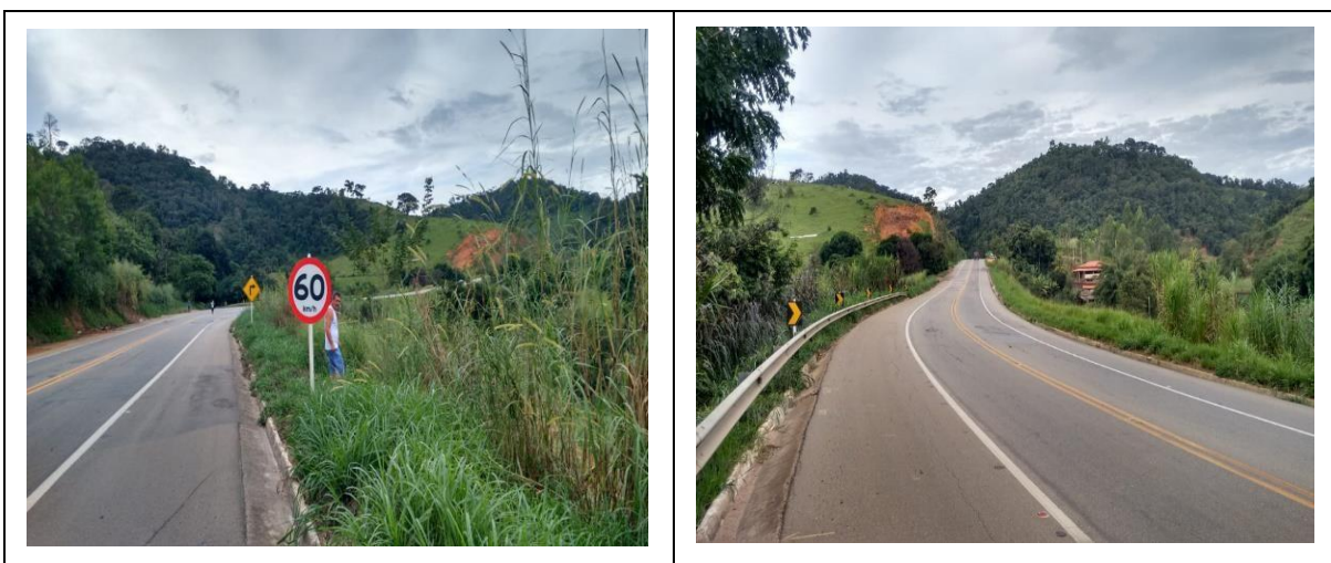
Figura 31 - Sinal de advertência e regulamentação (a) e Contenção da parte externa da curva circular (b)
